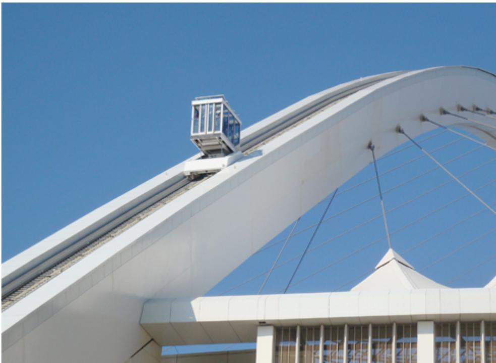
*Das „Moses Mabhida Stadium“ in Durban verfügt über einen geschwungenen, von Stahlseilen getragenen Dach-Bogen, auf dem eine Seilbahn Besucher auf 104 Meter Höhe transportiert. Die Energieversorgung der Seilbahn wurde von Conductix-Wampfler mit Schleifleitungen der SinglePowerLine realisiert.*
